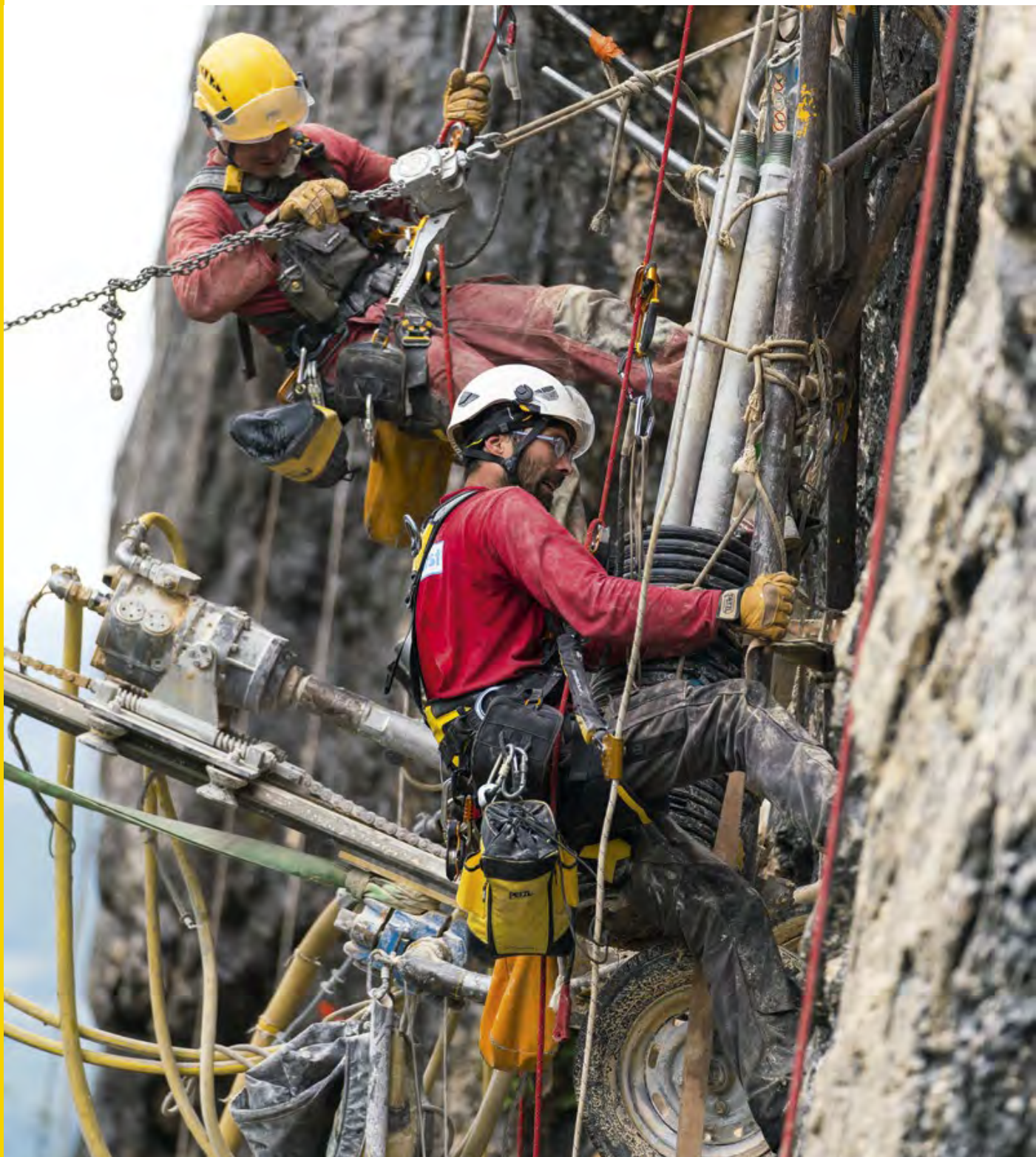
Road protection works in Gorges du Nan, Isère, France © Petzl - vuedici.org - Hydrokarst - Département de l'Isère
